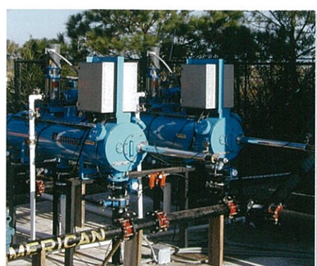
MT44P×2台並列設置 (米国下水最終処理・日量1,400m³処理)
