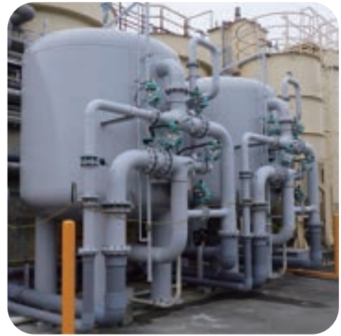
▲ろ過塔寸法 φ2,900mm×SH1,830mm
